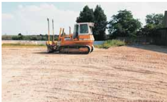
PREPARAZIONE DI SOTTOFONDI
